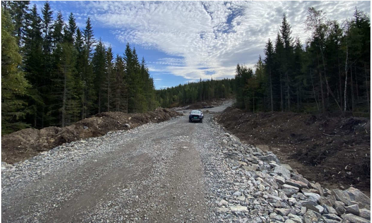
Bilde 8. Eksempel på lagring av vekstmasser klargjort for istandsetting av veiskråninger.
