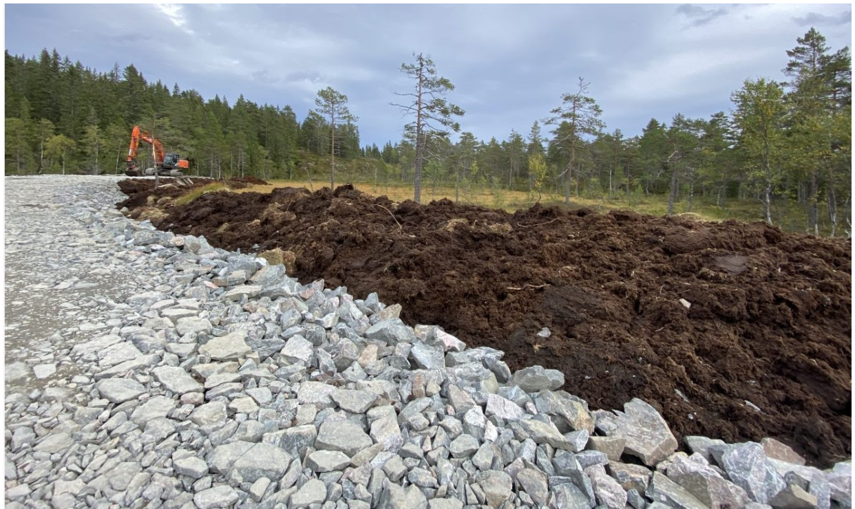
Bilde 7. Bygging av adkomstvei på myr. Veien går til WTG 32 og WTG 19.
