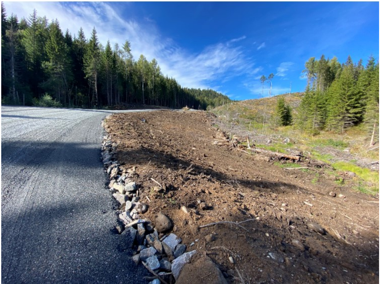
Bilde 1. Eksempel på istandsetting av vei Engerfjellet. Hogsten i området er utført av grunneier og er ikke en del av arbeidet med vindkraftverket.
