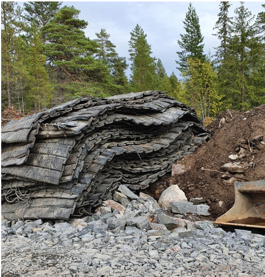
Bilde 11. Entreprenør benytter sprengingsmatter for å hindre spredning av sprengstein i terrenget.
